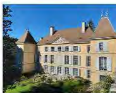
École/habitat participatif dans un chateau Mairie d'ouvrage: collectif de 15 foyers Mission partielle Etude en cours Monestier de Clermont - Trièves - Isère
