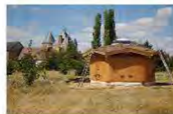
Le sanctuaire des abeilles Lieu de méditation au contact des abeilles Ossature bois, isolation paille, enduits terre, charpente auto-portée, toiture végétalisée, 6 ruches sont intégrées dans les murs MOA association Greenfriends Mission partielle Projet réalisé (2008) Région Centre
