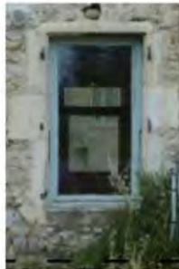
Exemple fenêtre au RDC Aile Ouest
