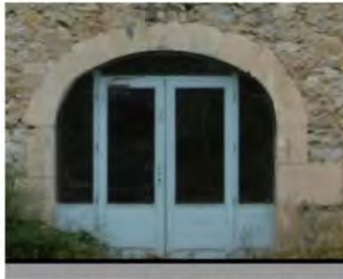
Exemple de porte-fenêtre au RDC Aile Ouest
