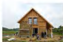
Maison Pitefeux Maison ossature bois et isolation paille MOA privée Mission partielle: études jusqu'au permis de construire Projet réalisé (2014) Hauts-de-France
