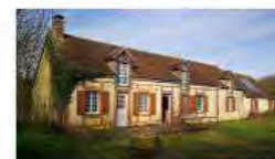
Maison Saint-Christophe Rénovation complète d'une maison en habitation secondaire MOA privée Conception générale jusqu'aux contrats de travaux Normandie
